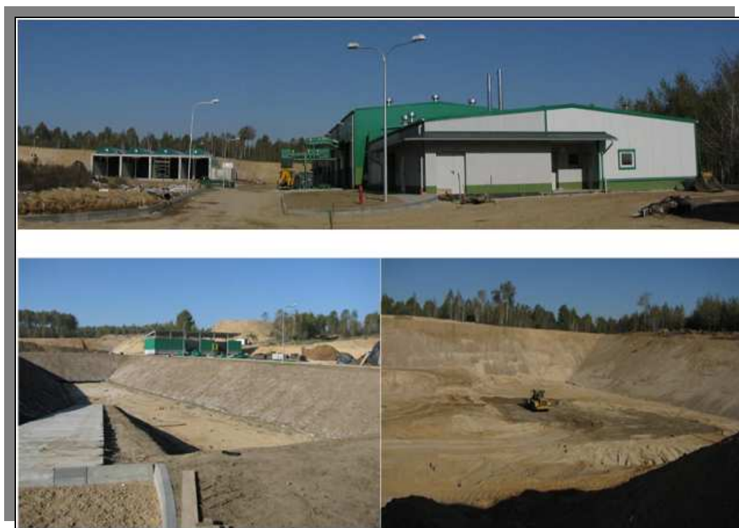
Rycina 30 Zakład Przetwarzania i Unieszkodliwiania Odpadów w Czerwonym Borze - kwatery odpadów azbestowych (w budowie)
