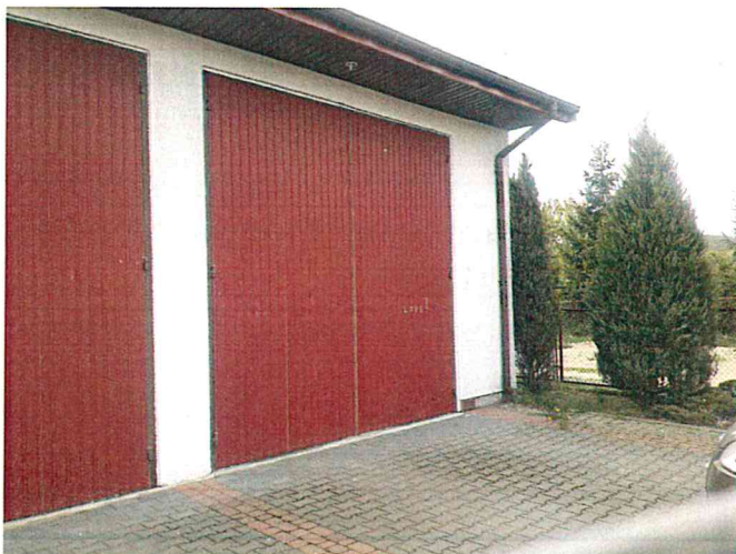
1. Widok bram przed demontażem
